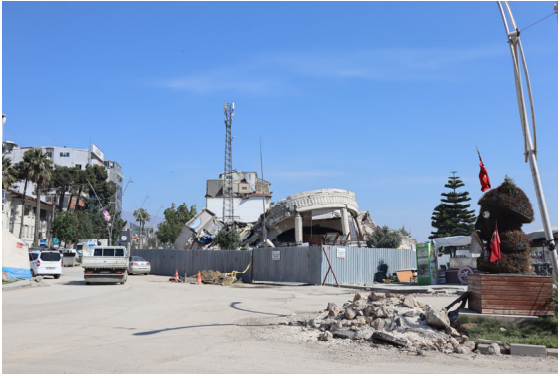
Photo 1-17 Antakya, Hatay. Former Parliament building. Hatay Devleti döneminde meclis binası.
