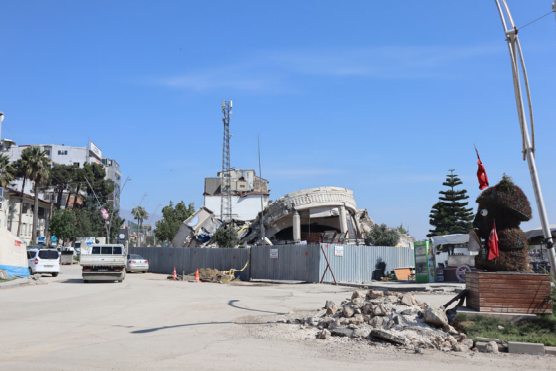
Photo 5-18 Antakya, Hatay. Former Parliament building. Hatay Devleti döneminde meclis binası.
