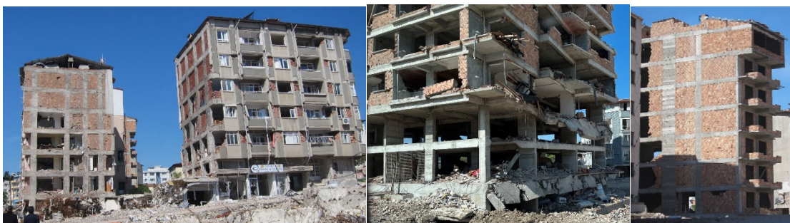
写真 3-4 被災した RC 造建物(左)と建設中の RC 造建物(中央・右)
