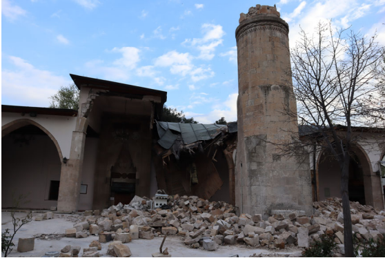
写真 5-1 ミナレットが倒壊し足元に石が転がっている エントランス付近が損傷している
