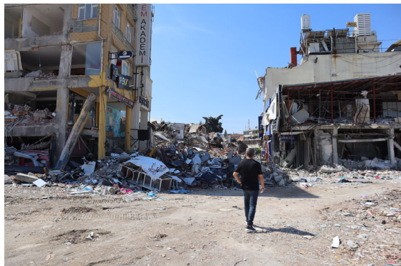
写真 1-23 ハタイ県アンタキヤ地区 Hürriyet 通り 瓦礫で埋もれている
