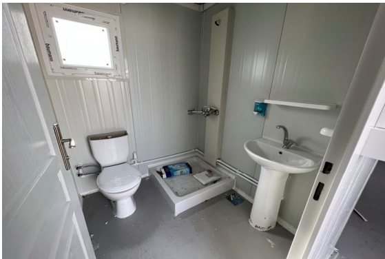
写真 4-17 コンテナ内部 トイレとシャワー、手洗い
