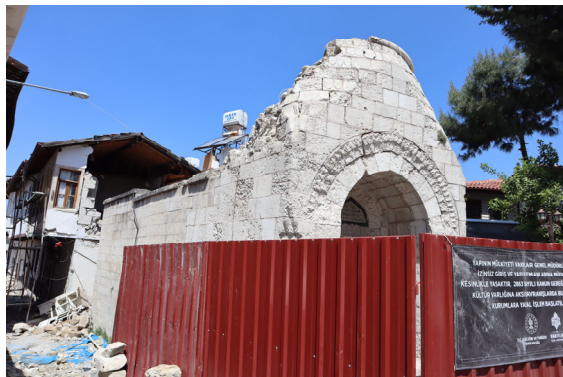
写真 5-21 ハタイ県アンタキヤ地区 Sarimiye Camii ミナレットが倒壊している
