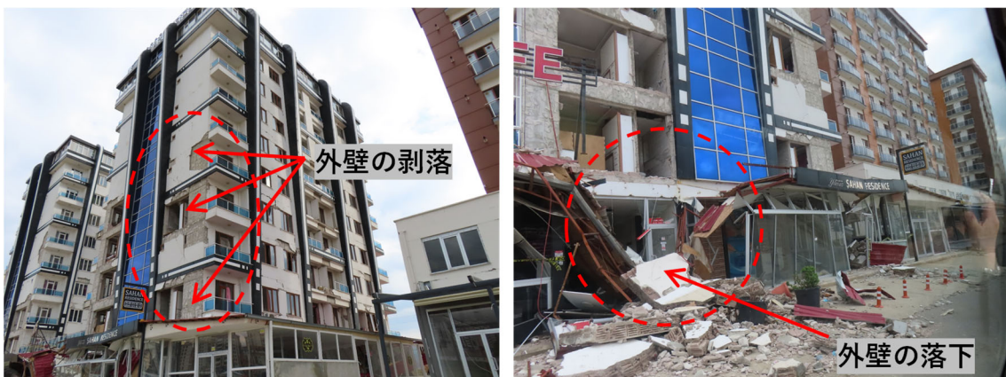
図 2-16 Kahramanmaras の地震被害状況(地点②)
