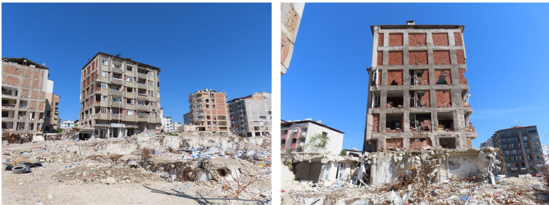
図 2-29 Antakya の地震被害状況（新市街地）
