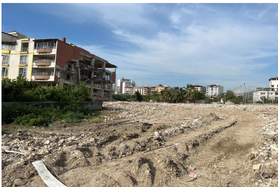
写真 1-50 ハタイ県サマンダー地区 増築建築が倒壊した現場
