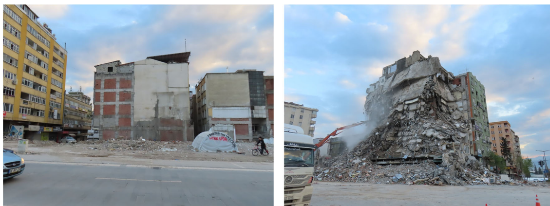
図 2-20 Kahramanmaras の地震被害状況(地点⑥)
