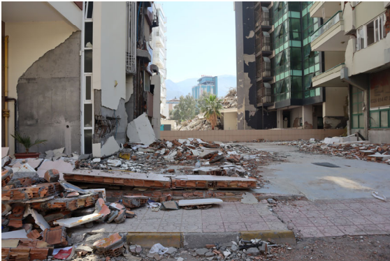
写真 1-57 ハタイ県イスケンデルン地区 集合住宅の外壁の剥落
