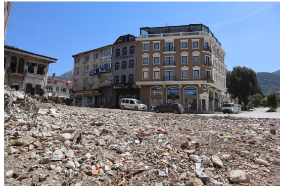
写真 1-40 ハタイ県アンタキヤ地区 無傷のホテルもあった
