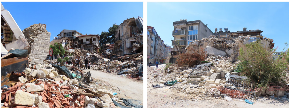
図 2-30 Antakya の地震被害状況（旧市街地）
