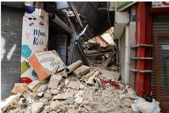
写真 1-47 ハタイ県アンタキヤ地区 Uzun Çarşı ロングバザール
