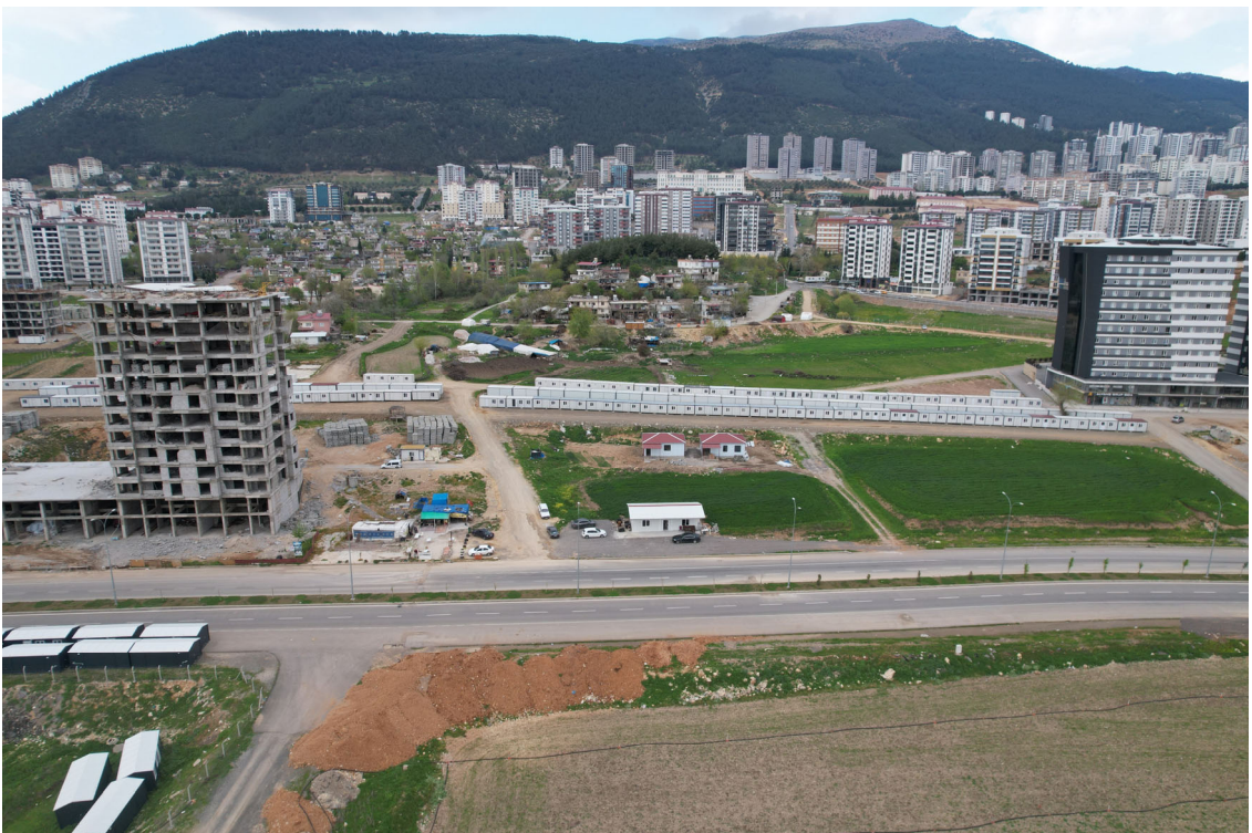
写真 1-3 カフラマンマラシュ県オニキシュバト地区 コンテナ仮設住宅をドローンで撮影 正面の白い建物が区庁舎
