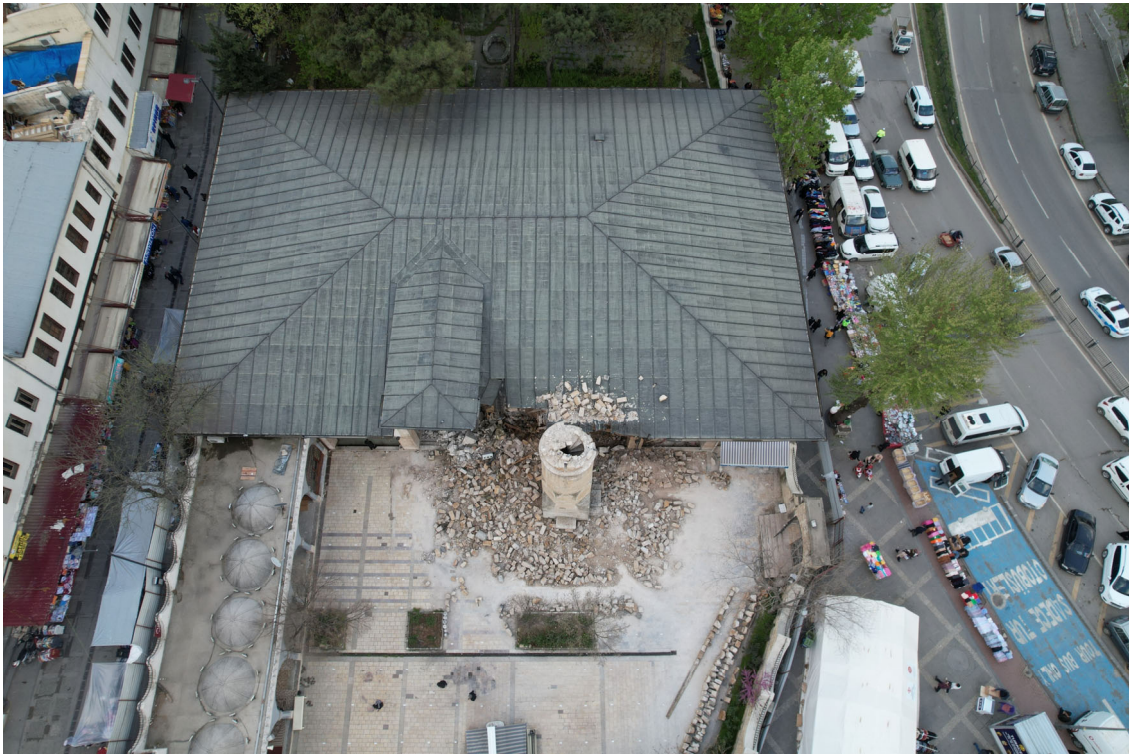
写真 1-11 カフラマンマラシュ県ドゥルカディオール地区 Ulu Camii ドローンで撮影 ミナレットが壊れて石が落下することで、建物が損傷していることがわかる
