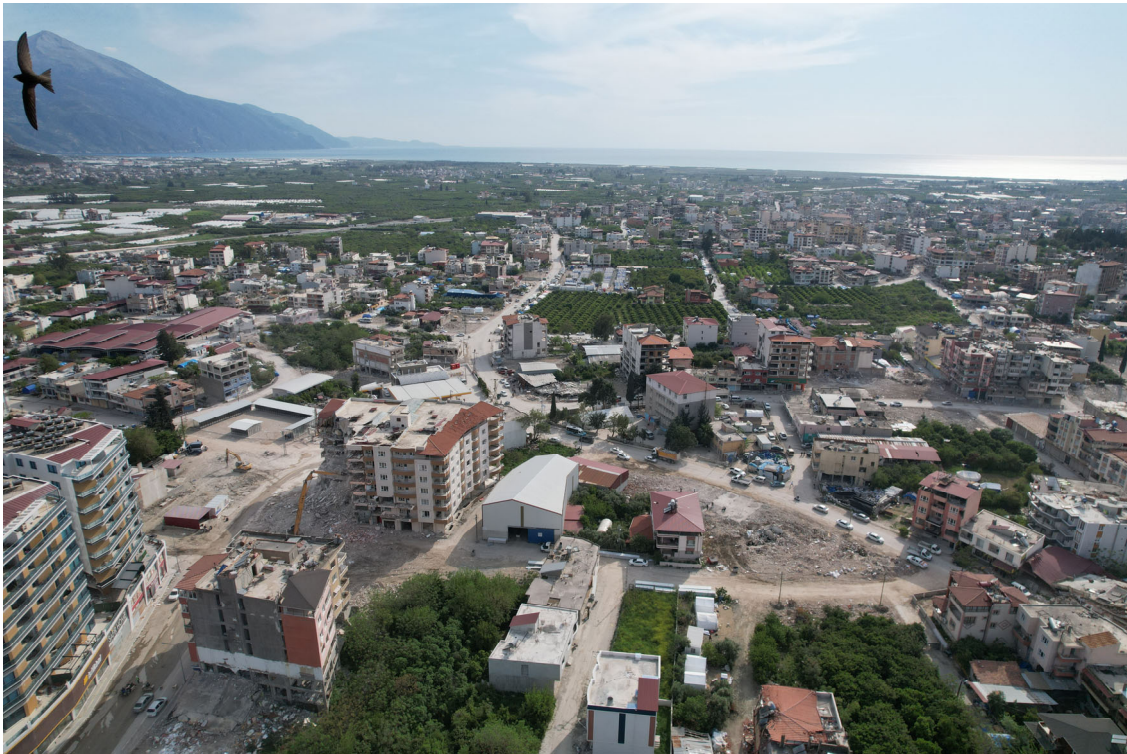
写真 1-49 ハタイ県サマンダー地区 多くの建物が倒壊、損傷している
