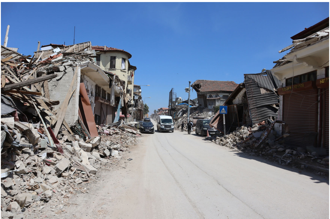
写真 1-41 ハタイ県アンタキヤ地区 Kurtuluş 通り
