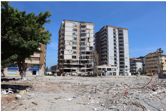
写真 1-60 ハタイ県イスケンデルン地区 解体予定の集合住宅
