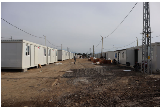
写真 4-13 コンテナ仮設住宅 335 戸 来週完成する 洗濯コンテナ、病院コンテナ、学校コンテナ等もある
