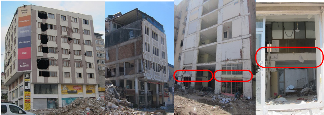
写真 3-2 商業利用される建物低層部および中 2 階(mezzanine)のある建物
