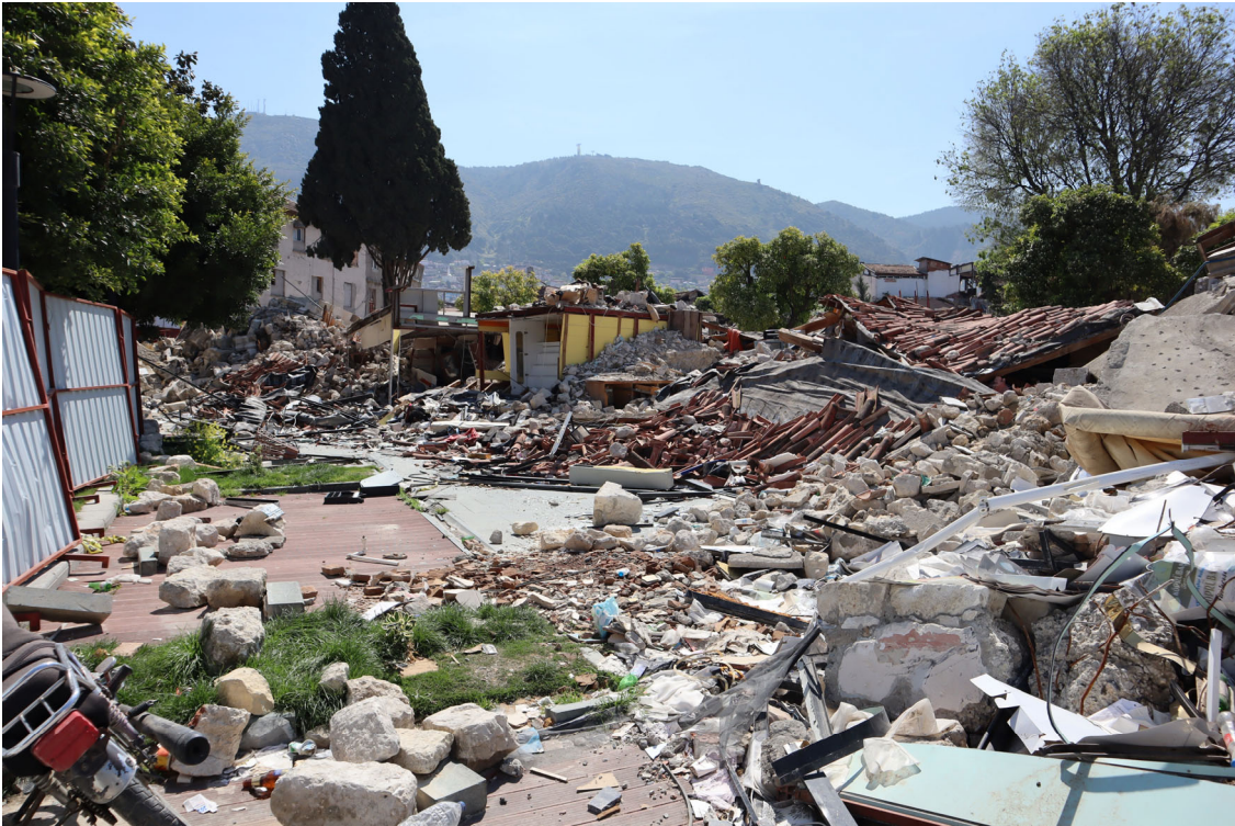
写真 5-17 ハタイ県アンタキヤ地区 ウルジャーミイ 正面の樹木の傍にミナレットが建っていたが、建物とともに全壊している
