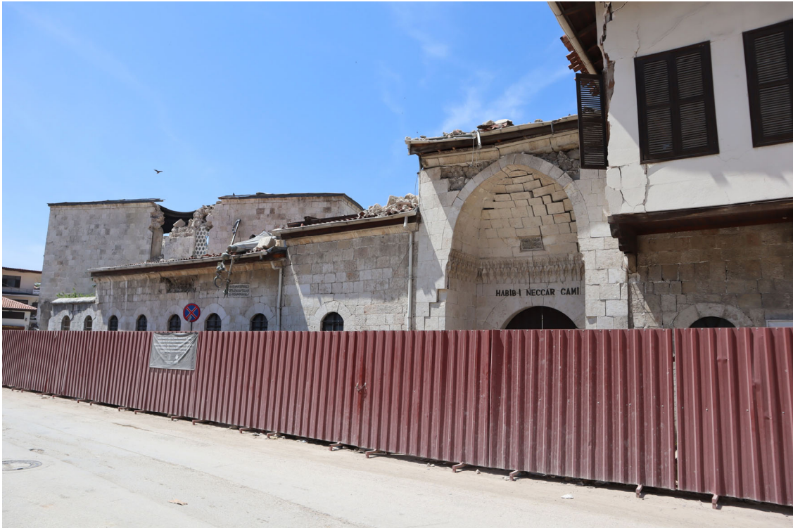
写真 5-22 ハタイ県アンタキヤ地区 Habib-i Neccar Camii ミナレットやドームが倒壊している
