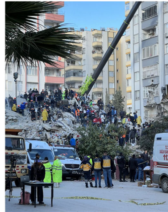
図 2-7 14階建て集合住宅の崩壊
