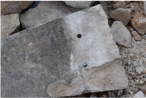
写真 5-8 倒壊したミナレットの石のほぞ穴
