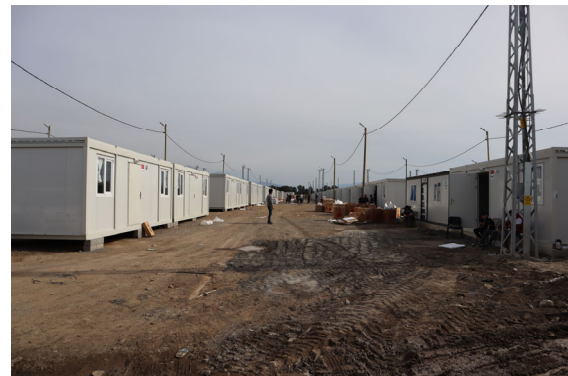
写真 1-69 ハタイ県パヤス地区 整備中のコンテナ仮設住宅
