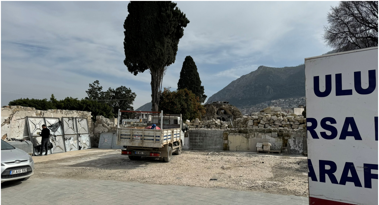
ウルジャーミ修復現場。ブルサ大都市自治体が修復を支援している。
