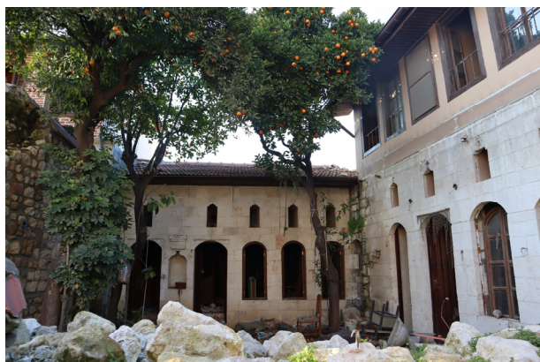
中庭 1階の石造壁の上部小窓で換気する 樹木が必ず植えられる
