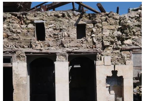
玉石(栗石)組積壁と切石の外装
