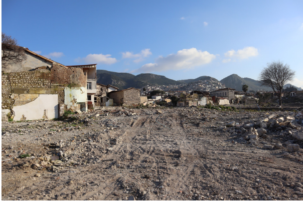
旧市街。瓦礫が整理された風景が広がる。
