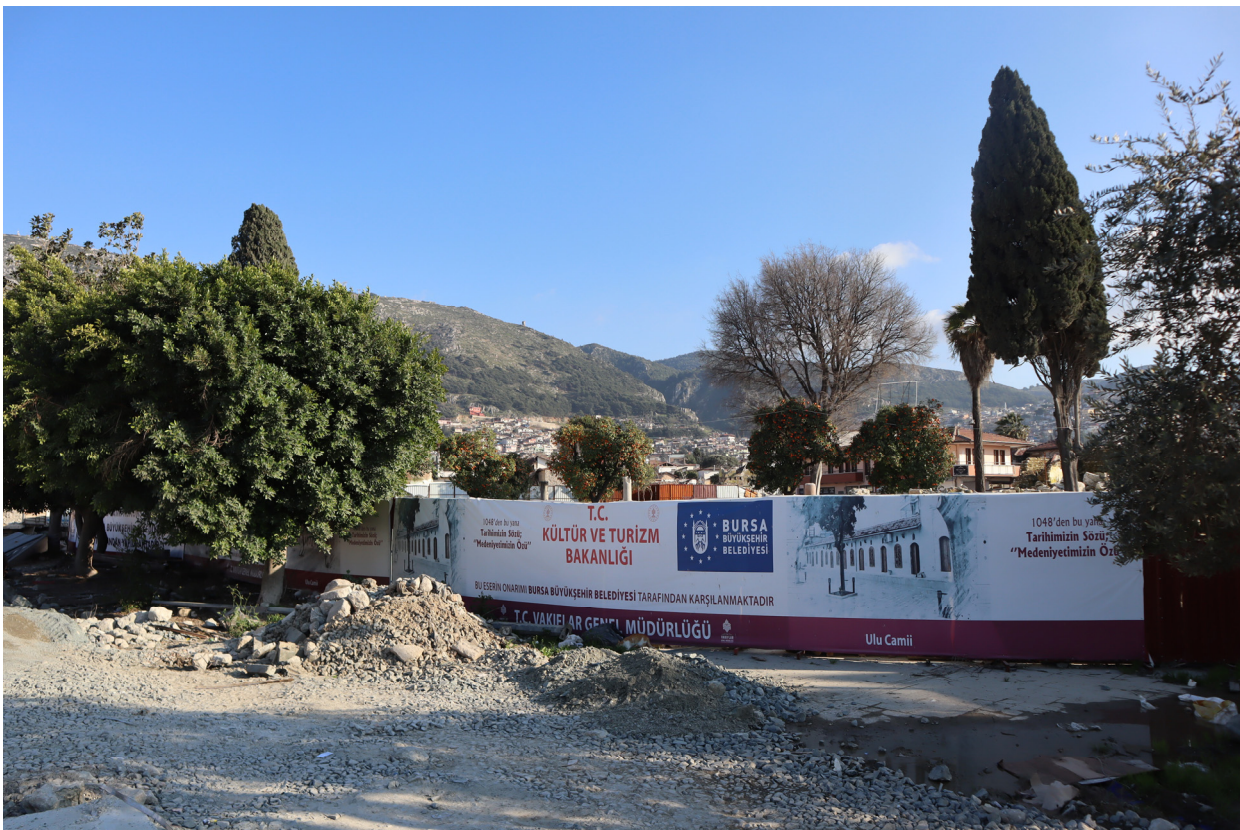
ウルジャーミィ修復現場。国が仮囲いを施している。ブルサ大都市自治体が修復を支援している。
