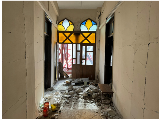
左の建物の内部。
