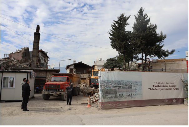
サルミエジャーミイ修復現場。
