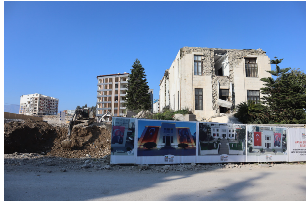
ハタイ大都市自治体市庁舎の修復現場。同自治体が修復を主導。
