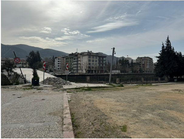
アシ川沿いの既存の中層建物
