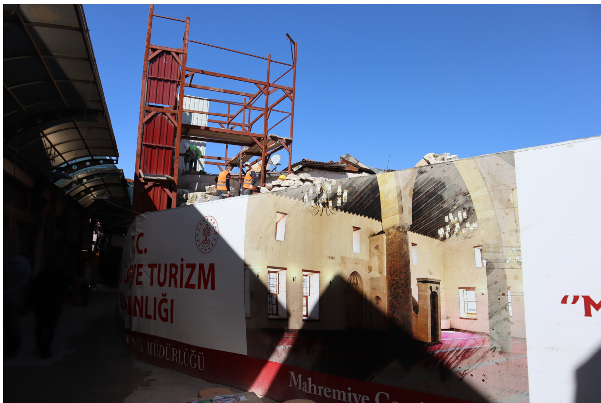
マフレミエジャーミイ修復現場。ミナレットを解体しているところ。
