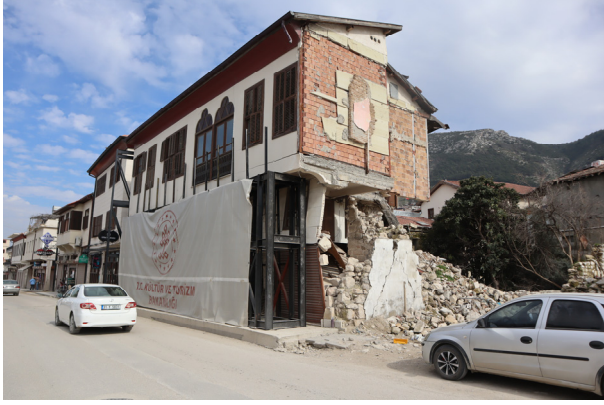
クルトゥルシュ通りの文化財建造物。 倒壊しないように鉄骨で支えている。
