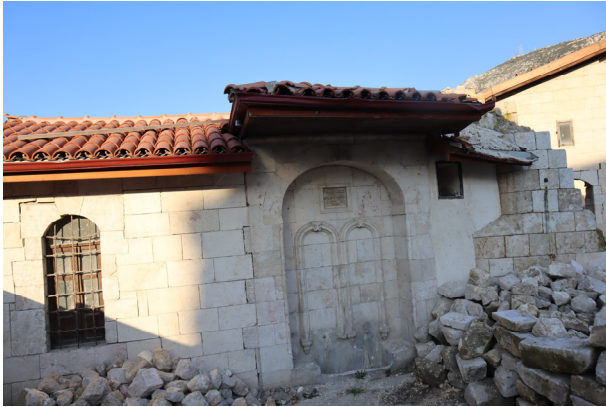
修復現場のジャーミイの外観 壁は切石積み 屋根瓦はアラトゥルカ
