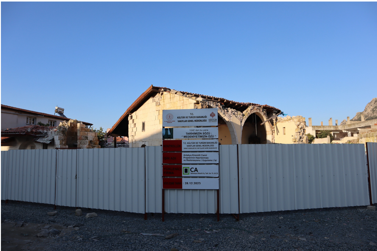
壊れたジャーミィ (=モスク) は、国が必ず仮囲いをしている。囲いのみで、修復はまだ始まっていないものが多い。
