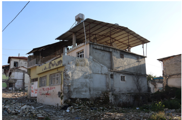
RC造の建物 小屋組は鉄骨 景観にそぐわない
