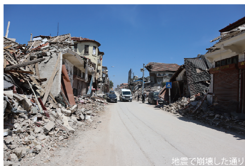
地震で崩壊した通り
