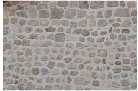
玉石(栗石)組積壁の外観
