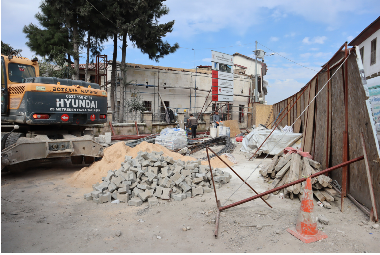
サルミエジャーミイ修復現場。国が仮囲いを施している。ラマダンまでの完成を目指して急ピッチで工事が進められている。
