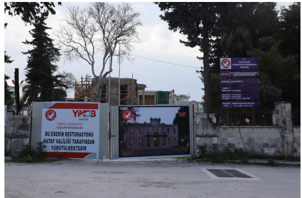
ハタイ県の建物。修復工事が進む。
