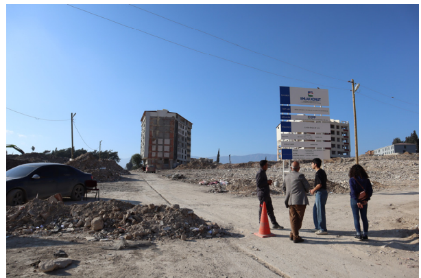
新市街の様子。地盤改良工事が進む。
