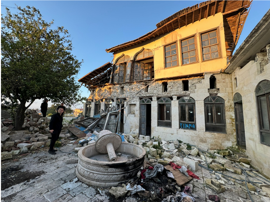
崩壊した住宅 そのまま放置されている
