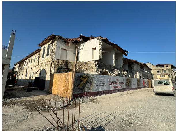
クルシュンル・ハンの修復現場。
