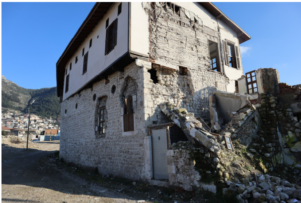
1階は石造 2階は木造 パーダーディと呼ばれる伝統構法
