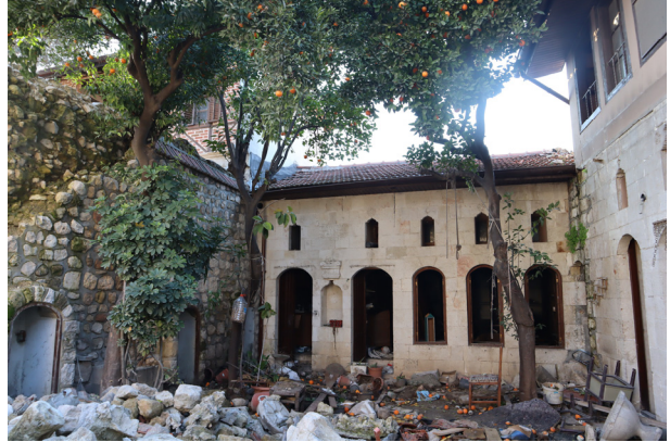
中庭 1階壁は切石積みや丸石積み 2階は木造 屋根瓦はマルシリア
