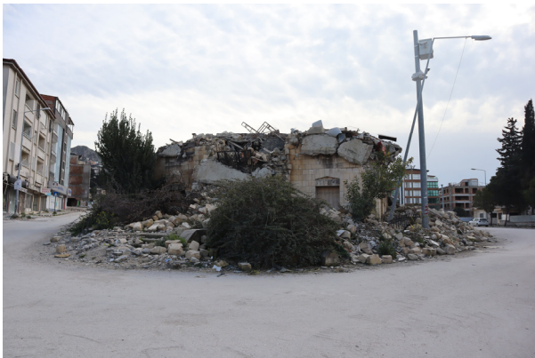
プロテスタント教会。壊れたまま残されている。
