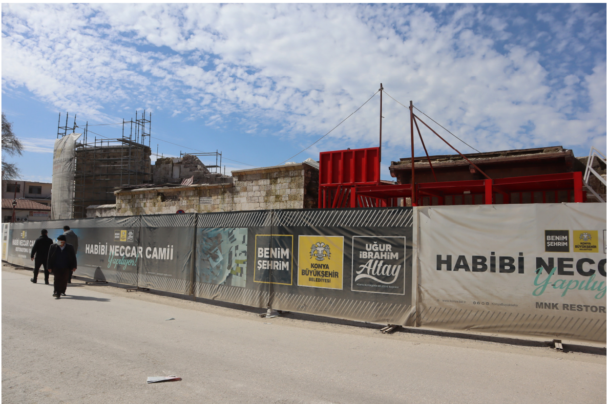
ハビビネッジャールジャーミイ修復現場。国が仮囲いを施している。コンヤ大都市自治体が修復を支援している。
