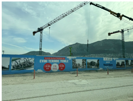
新市街の川沿いの集合住宅建設現場
