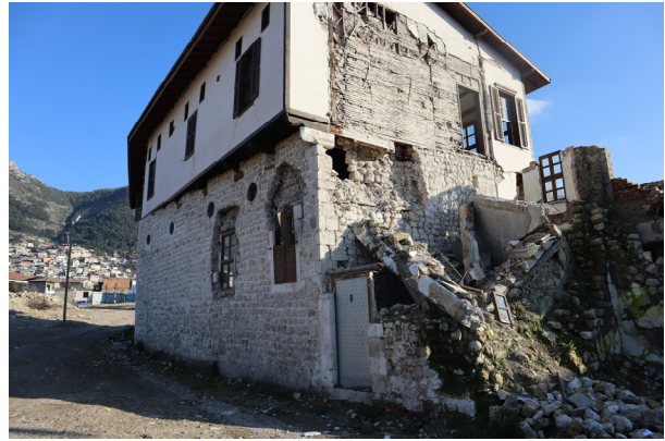
ジュンバと呼ばれる、2階が張り出す伝統的な形態。 1階は石造。2階は木造。木造の手前側壁面はパーダーディ。
