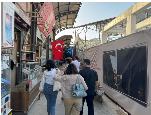
右側に再建中のマフレミエジャーミイの覆屋が見える。
