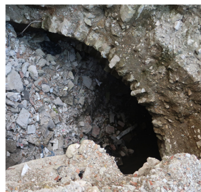
露呈したローマ時代の暗渠
