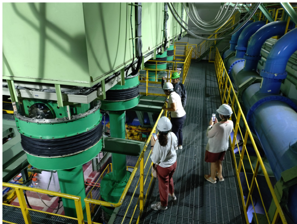
兵庫耐震工学研究センター（E-ディフェンス）を視察。
