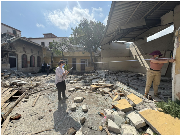
実測調査の様子。
